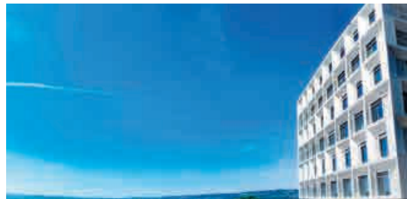
Der Neubau des Kantonsspitals in Frauenfeld.
