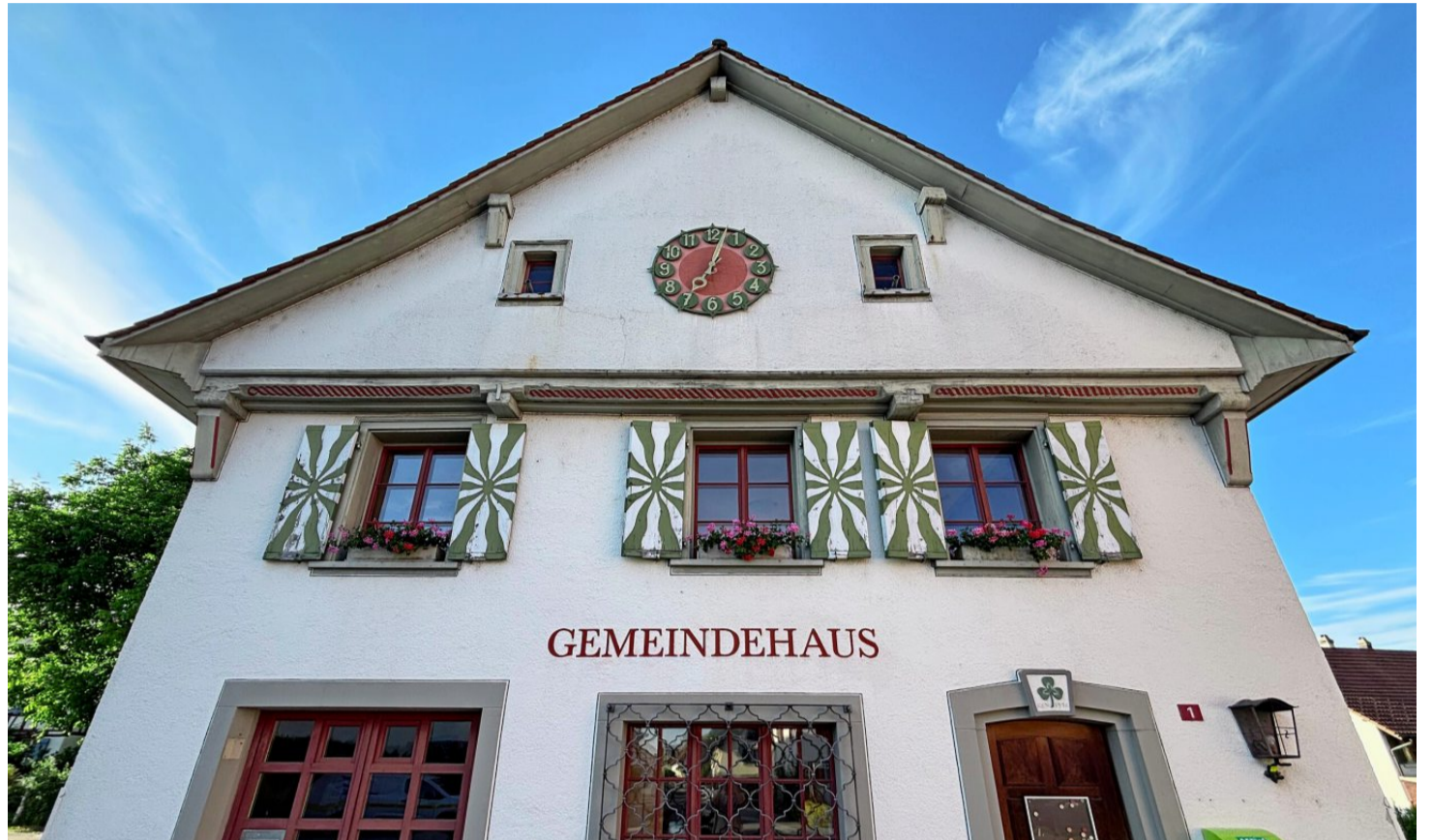
Das alte Basadinger Gemeindehaus: Im ersten Stock entsteht ein Übergangs-Kindergarten.
